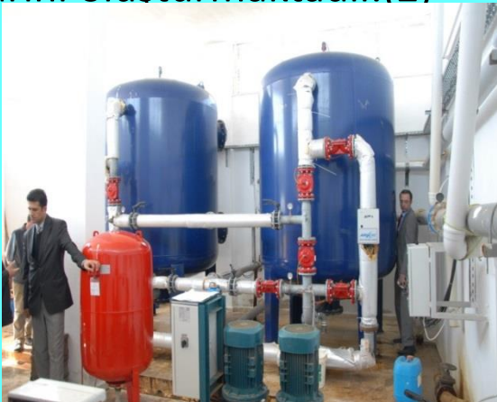
Şekil:9.Tipik FeCl3 + SO4^2- Arıtma yöntemi
